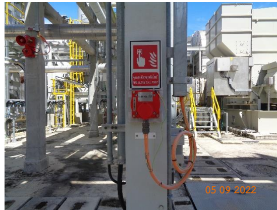
รูปที่ 2-26 สัญญาณแจ้งเหตุเพลิงไหม้
