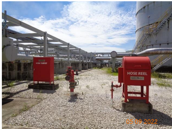
รูปที่ 2-25 หัวจ่ายน้ำดับเพลิงและตู้ดับเพลิงพร้อมสายน้ำ
